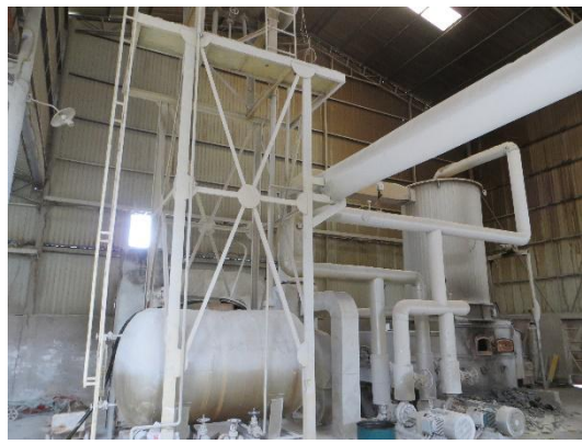
拟拆除的气粉混合机
