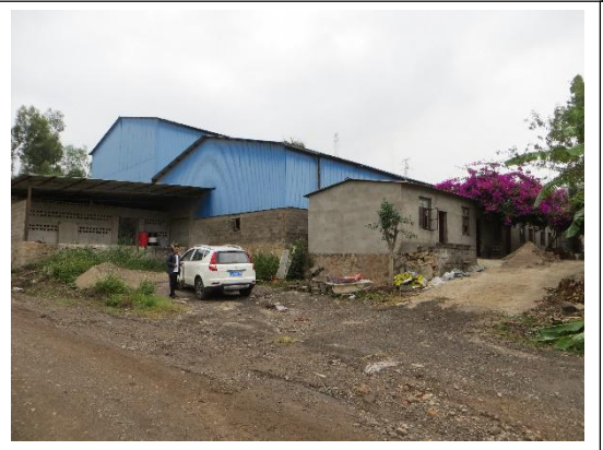
拟建项目现状场（西北侧）
